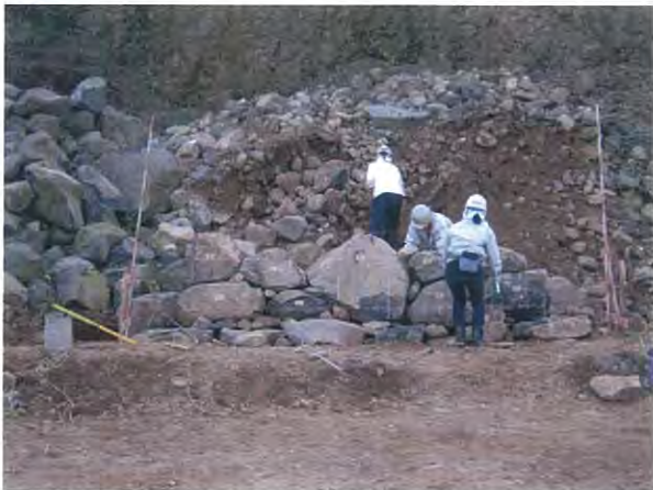
解体修理を想定した番号付けやメッシュ記録実習
